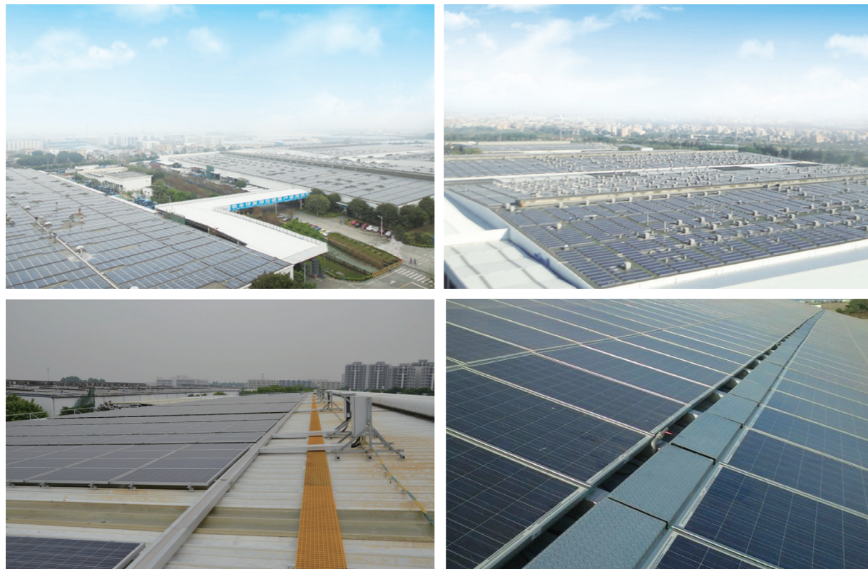
Panel fotovoltaico instalado en la fábrica de CAC de Midea
